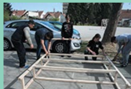
Izgradnja konstrukcije visećih vrtova
